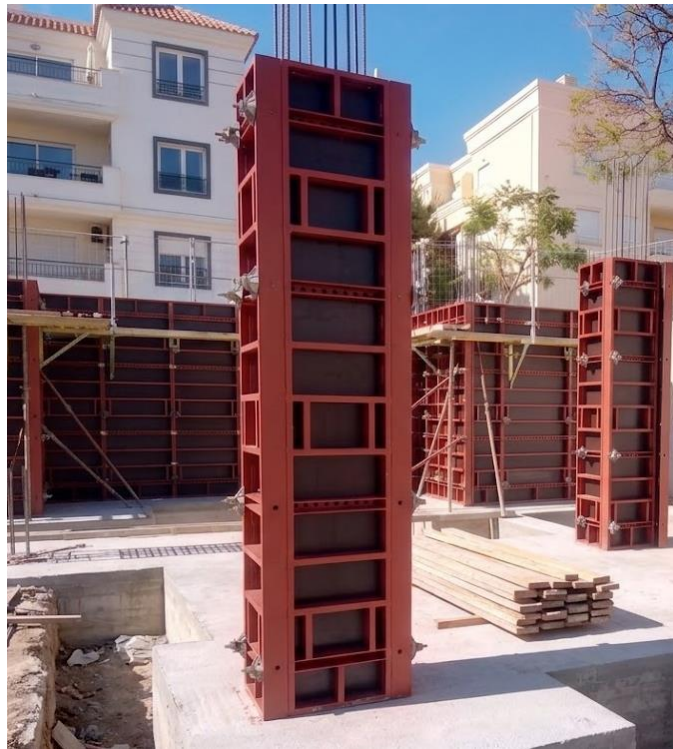
Vue de chantier
