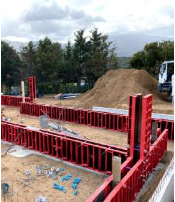
Vue de chantier
