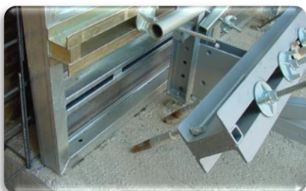
Fixation avec ancrage perdu
