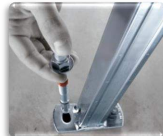
Amarre con varilla y resina
