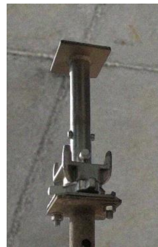
Cabezal de caída desbloqueado en forjado
